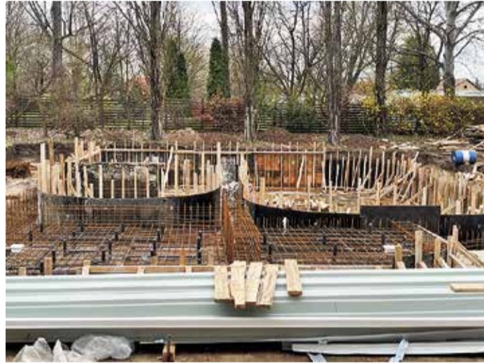
Betonozásra vár az új szabadtéri medence
